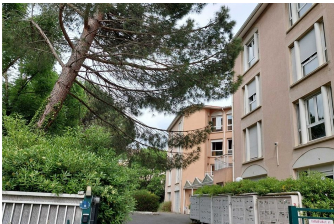
63 personnes sont actuellement hébergées au sein de cette résidence étudiante située dans le quartier de Jolimont. (©Maxence Dourlen/Actu Toulouse)
